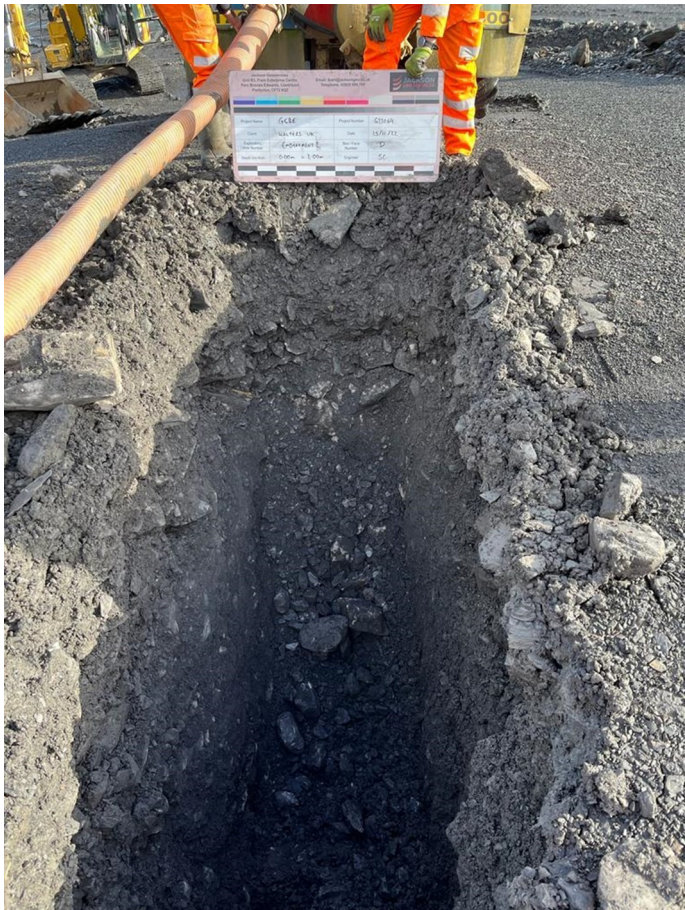
Embankment 2 Soakaway Face D
