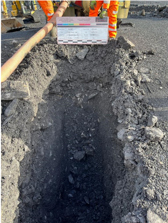
Embankment 2 Soakaway Face D
