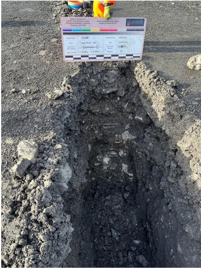
Embankment 2 Soakaway Face B
