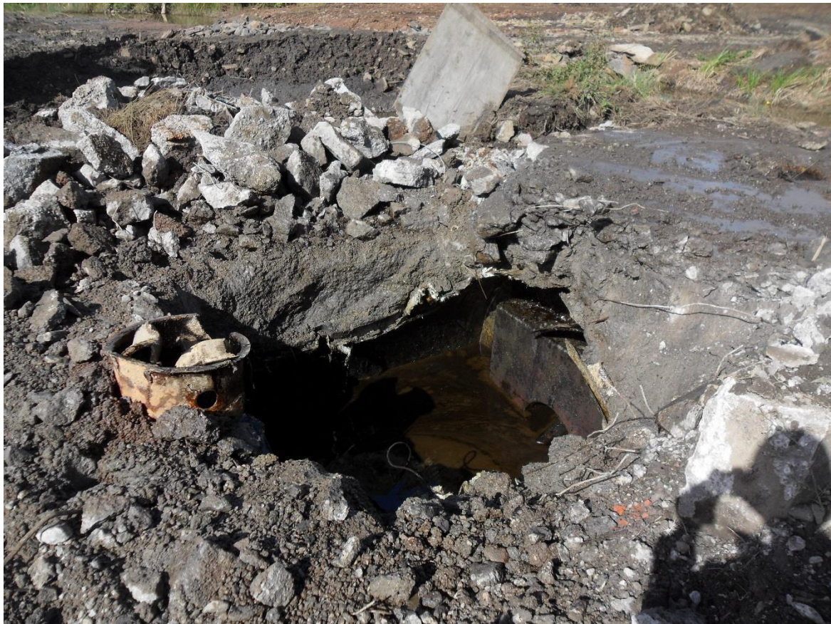
12) Inside the separator
