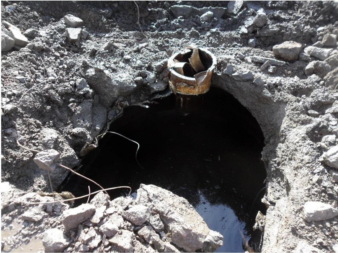
11) Inside the separator
