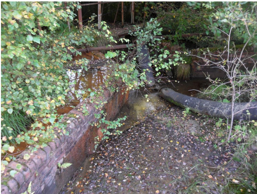
6) Effluent weir discharging to the SSR
