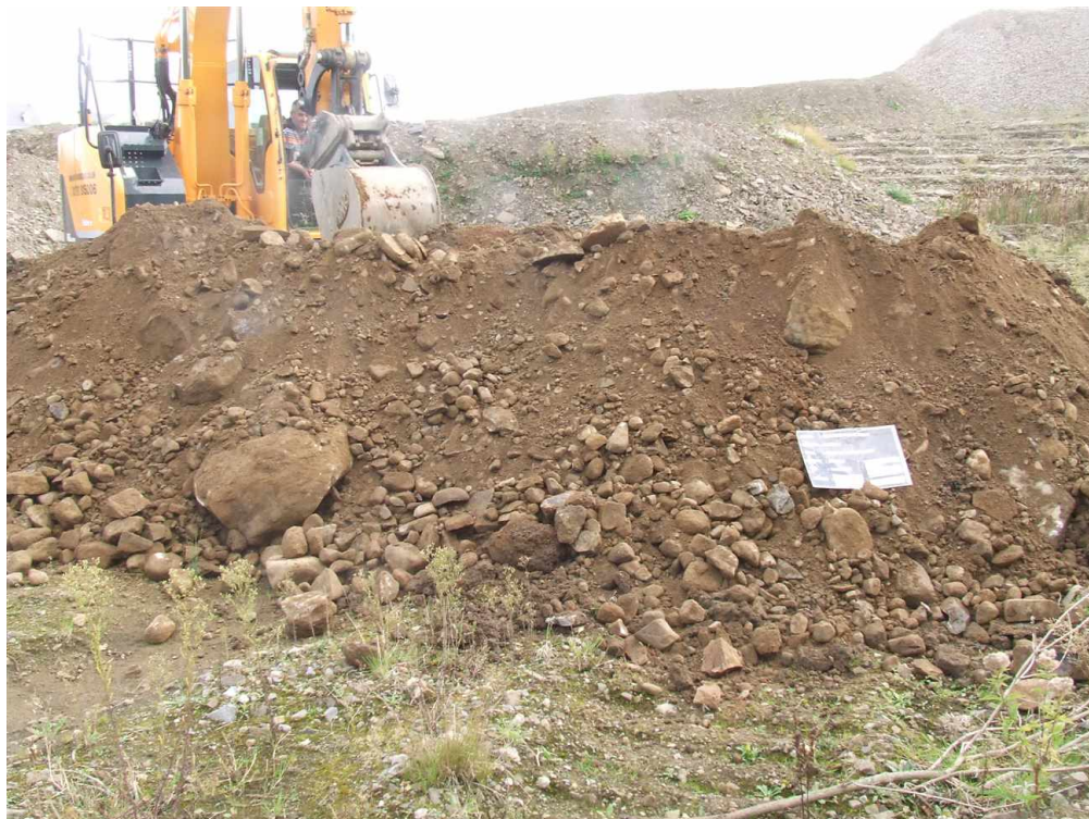
TP35 redig spoil
