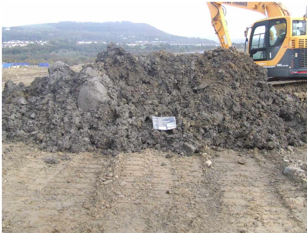
TPI7 redig spoil
